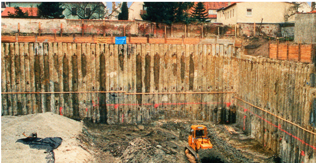
Tiefgarage in Donauwörth
