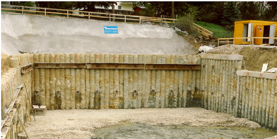
Wohnhaus in Mering
