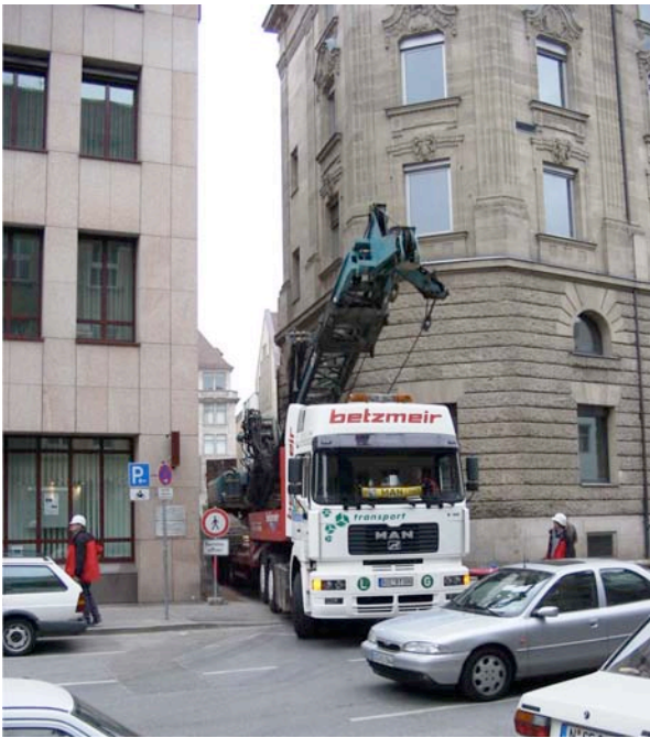
Bild 6: Einfahrt zur Baustelle (Ebracher Gässchen)
