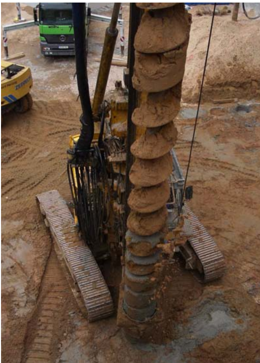
Bild 2.1: Bohrgerät mit Endlosschnecke \varnothing 75 cm
