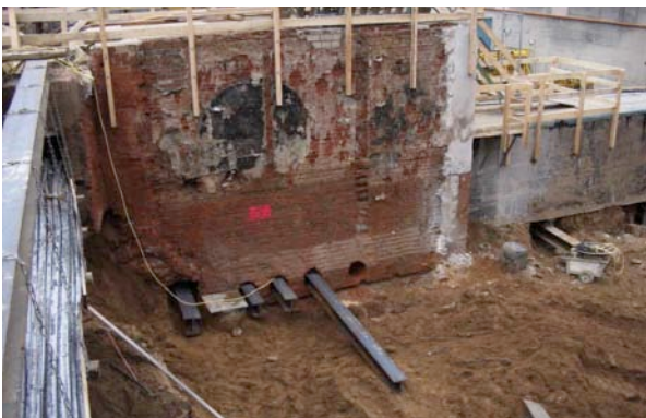
Bild 3: IPB-Träger werden unter dem Bauwerk durchgeschoben
