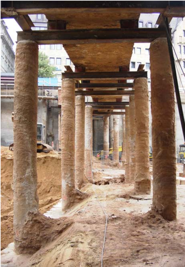
Bild 4: Die freigelegten Pfähle tragen den Kabelkanal
