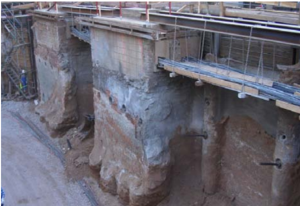
Bild 14: Unterfangung der Kabelschächte.
