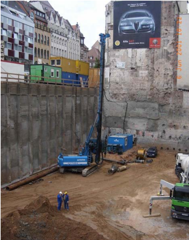
Bild 15: Unterfangung Joosten mit Spritzbeton im Hintergrund.
