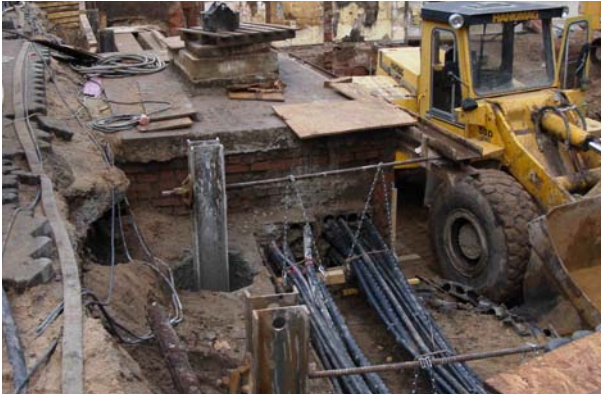
Bild 13: Steckträger aus Pfählen neben vorhandenen Leitungen.
