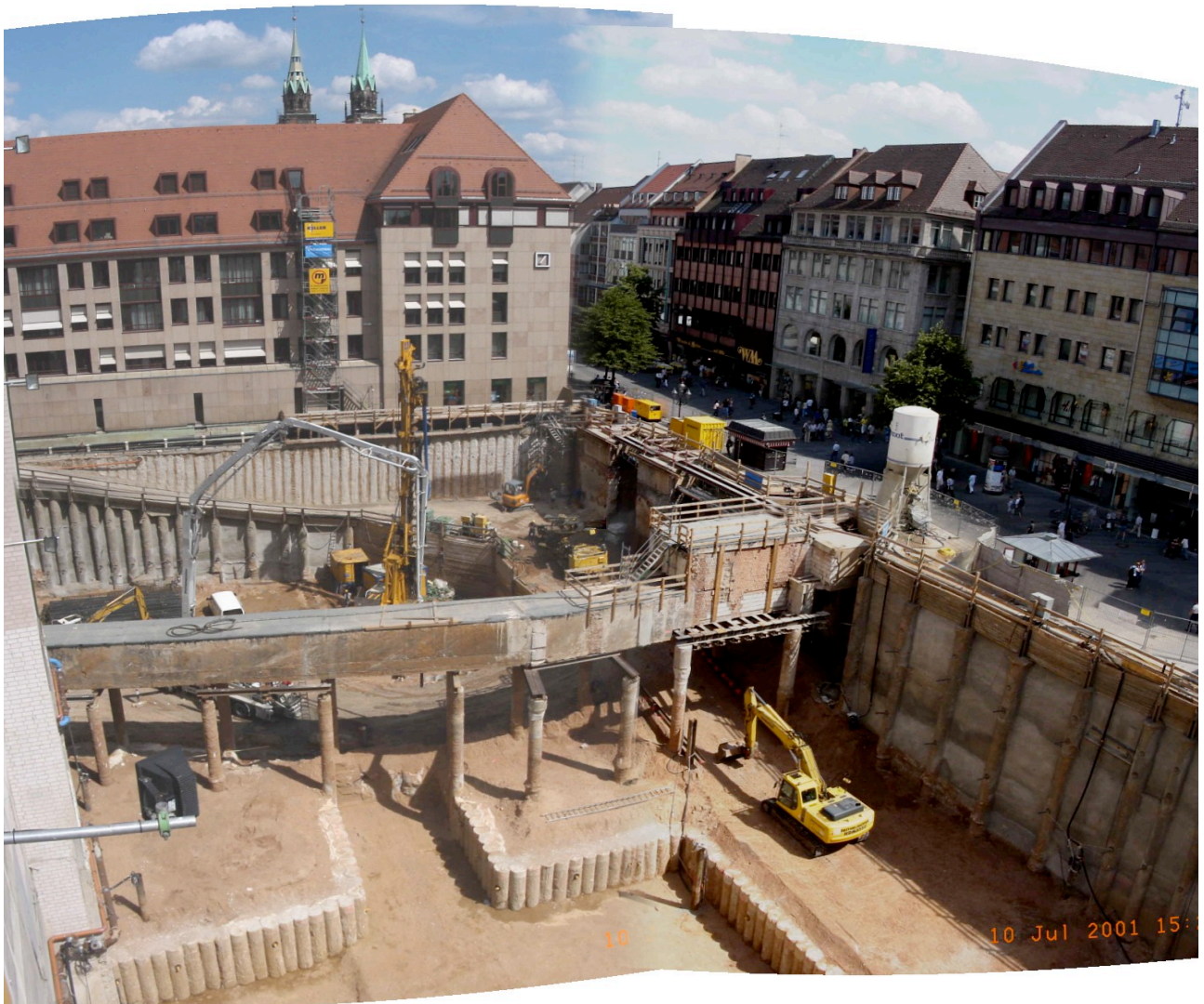
Bild 16: Blick in den Ostteil der Baugrube mit dem Kabelkanal.
