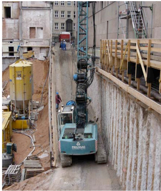
Bild 6.1: Auch die Bohrgeräte wurden über die Rampe eingefahren
