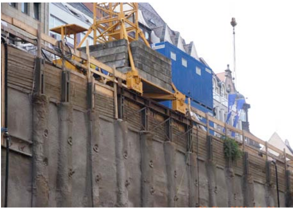
Bild 12: Hochbaukran balanciert auf den Steckträgern.
