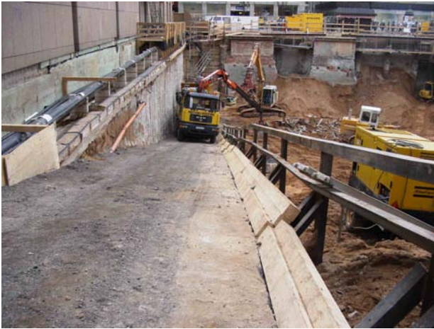
Bild 8: Rampe mit Absturzsicherung
